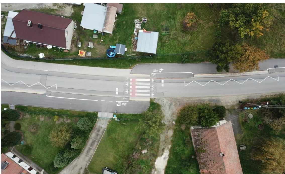
Rysunek 26. Gmina Oleśnica – przebudowa drogi powiatowej 1474 P
