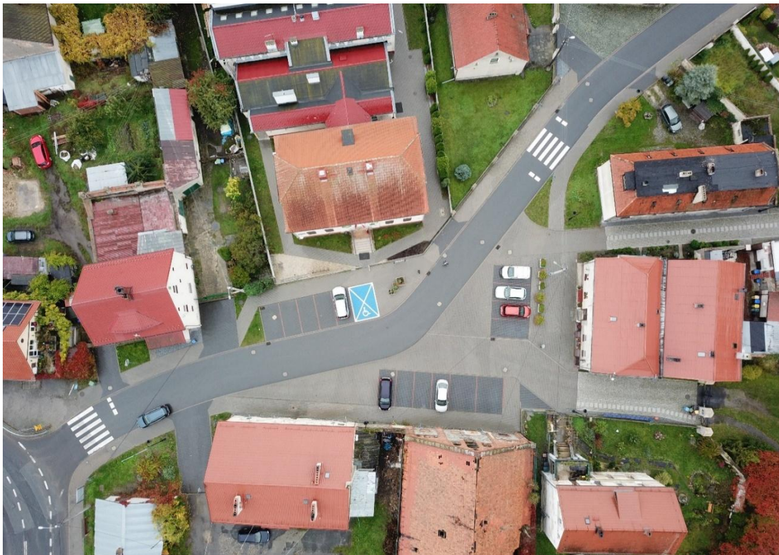
Rysunek 8. Gmina Borów – przebudowa ul. Szkolnej
